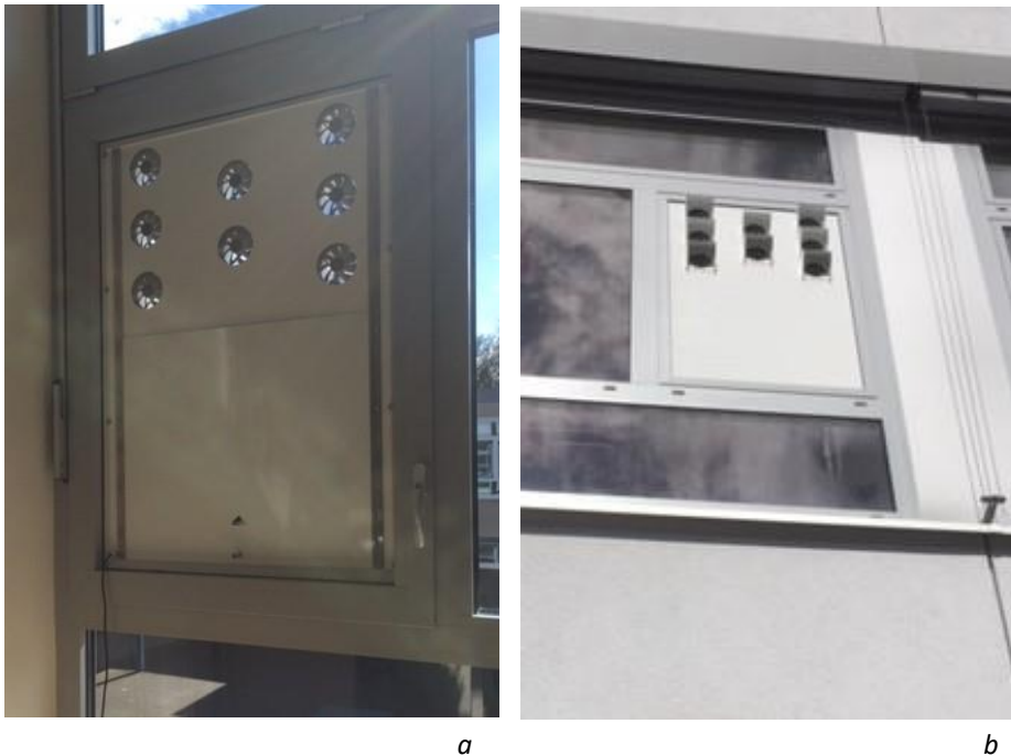
Bild 1 Lüftungs-Paneel „AirContinui“ – Innenansicht (a) und Außenansicht (b)
